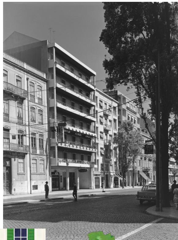
Define regras para os limites da volumetria dos novos edifícios (7 pisos), profundidade de construção (12m), para o ensombramento e desafogo das fachadas e recuo dos pisos terrosos (3,75m), para permitir alargamento das zonas de circulação pedonal através de galerias comerciais sem alterar o alinhamento dos edifícios, nem imputar os custos do acréscimo de espaço público ao município.
